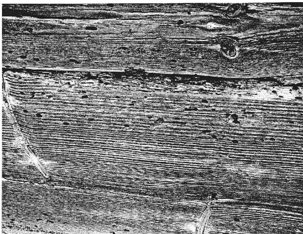
Fot. 6 Jeden z elementów (sumik) zniszczonych przez owady
